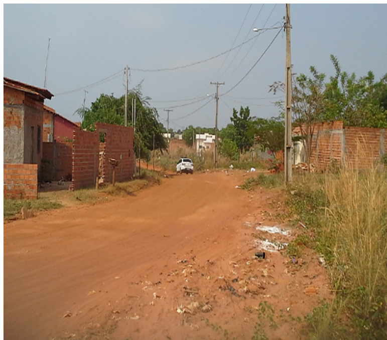
Figura 3 - Casas construídas sobre antigo lixão
